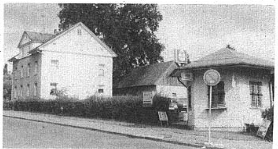
Dieses Anwesen an der Cent war das Zuhause der Wertheims. (Bilder: Erich Ruhl)
